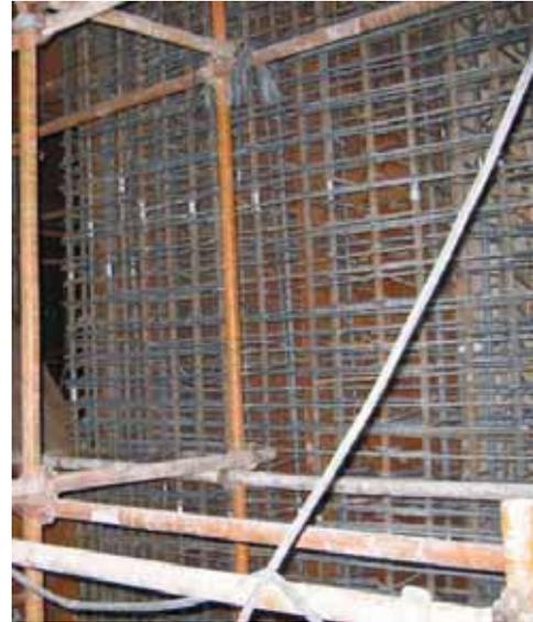
d. 綁紮混凝土牆體配筋後的鋼板牆
